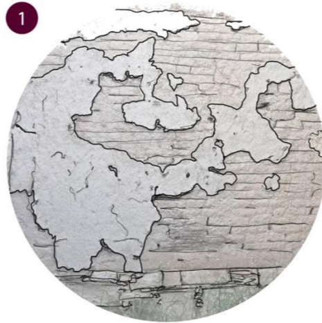
1 Αποκατάσταση επιχρίσματος τοιχοποιίας και πέτρας
